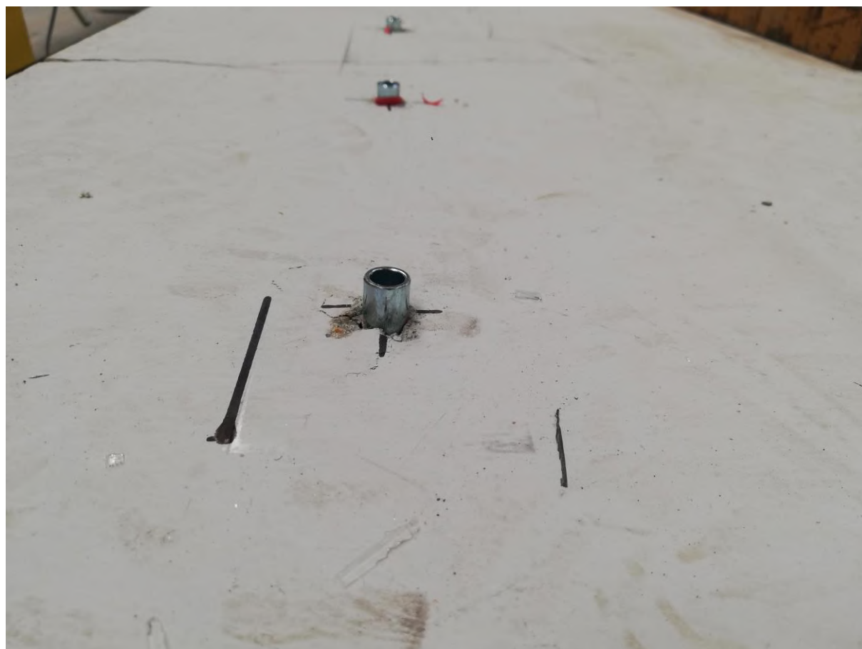
Próbka AL04-1 - wyrwanie kotew mechanicznych
